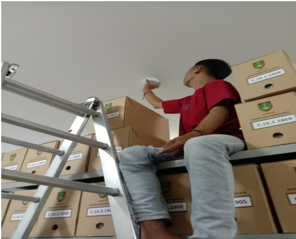
Gambar 3c. Pekerjaan teknisi uji coba Fire Alarms
