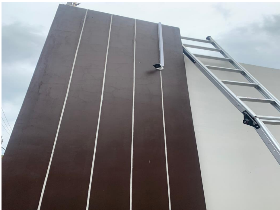
Gambar 3a. Pekerjaan teknisi pemasangan kamera CCTV Outdoor
