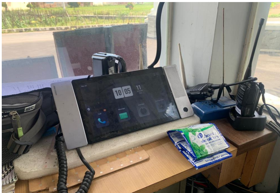
Gambar 3e. Pekerjaan teknisi pemasangan master intercom di kawasan perumahan Botanical Colomadu
