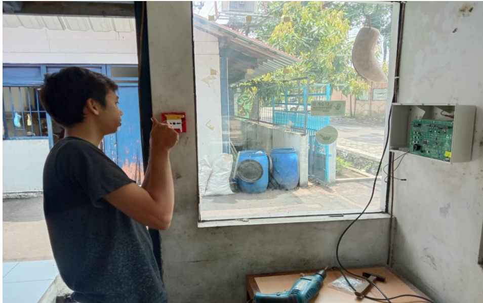
Gambar 3b. Pekerjaan teknisi pemasangan Fire Alarms
