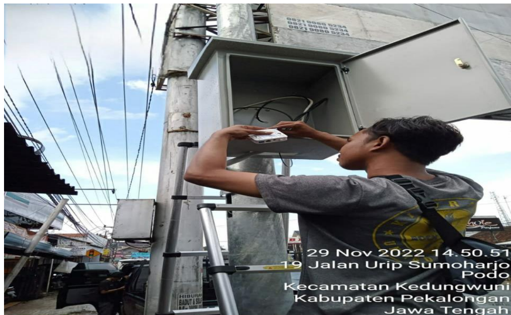
Gambar 3d. Pekerjaan teknisi proses pemasangan kamera E- Tilang di pekalongan
